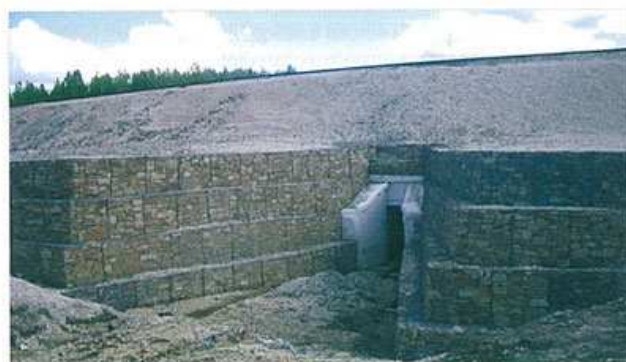
Укрепление габионами откоса насыпи железной дороги
